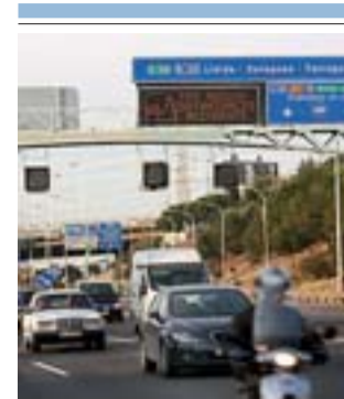
Aspecto de la B-32.
